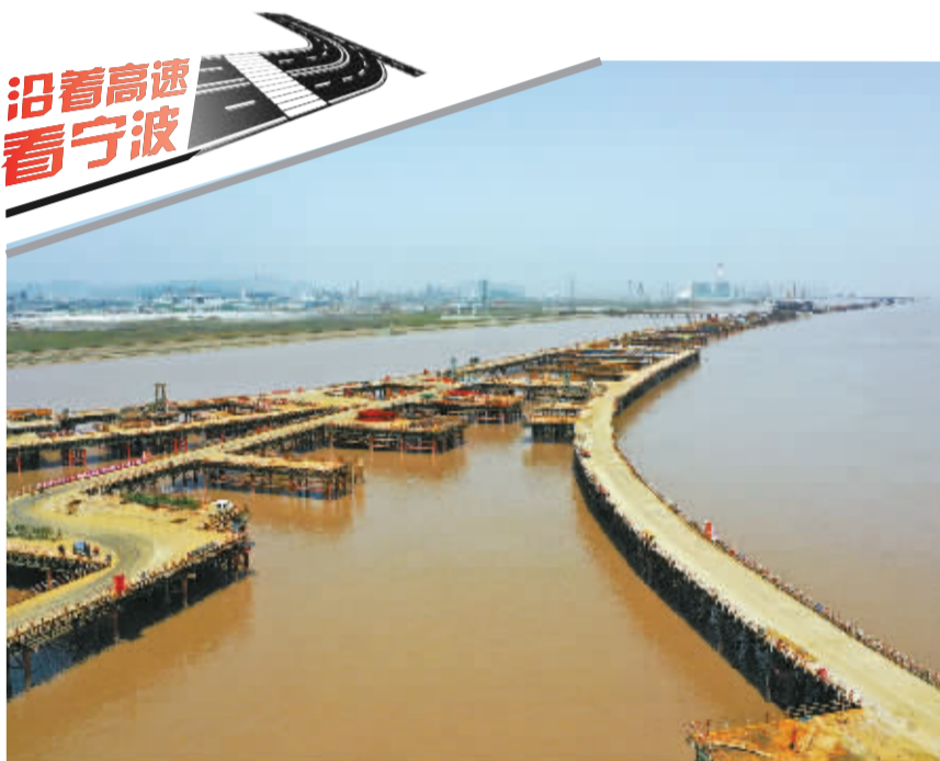
杭甬高速复线宁波段一期工程。记者 杨辉 摄
