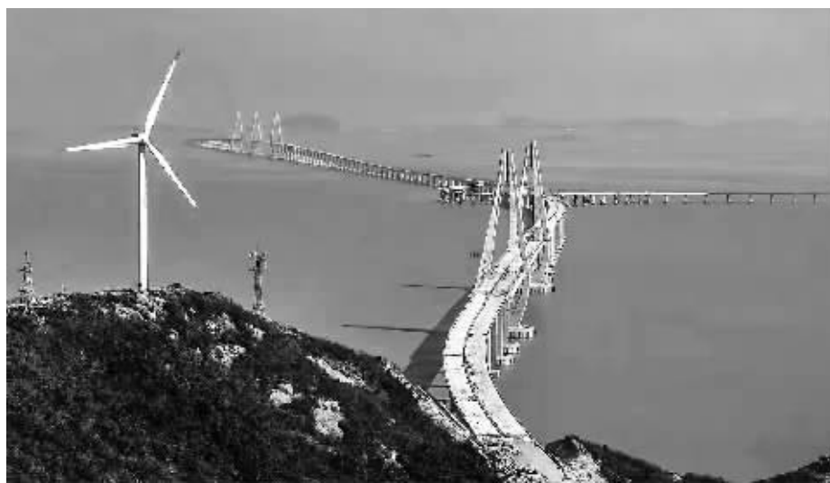
建设中的舟岱大桥 受访者供图
