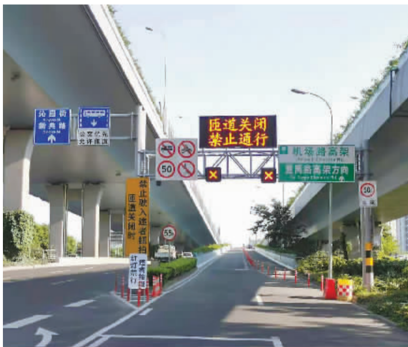
已启用车道信号灯调节管控的机场路高架中山西路南侧北往南上行匝道。受访单位供图
