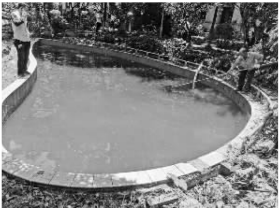
未清理的戏水池蓄满了雨水。
