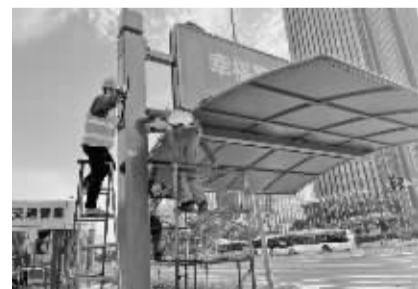
工人正在维护遮阳雨棚。
