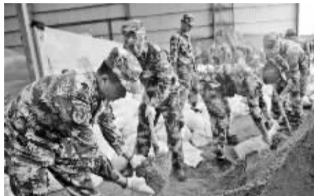
各单位抽调精兵对大榭海堤进行加固。
