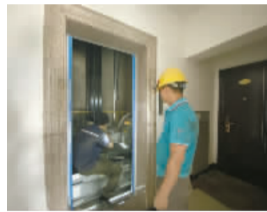
工人正在调试新装的电梯。
