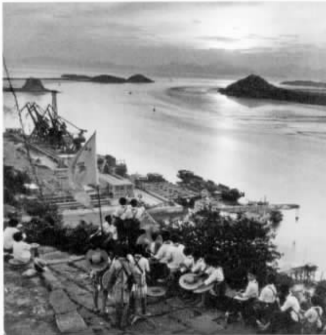
1978年镇海港万吨级煤炭专用码头竣工,为宁波港第一个万吨级码头。当时,大、小游山尚朦胧在目。
