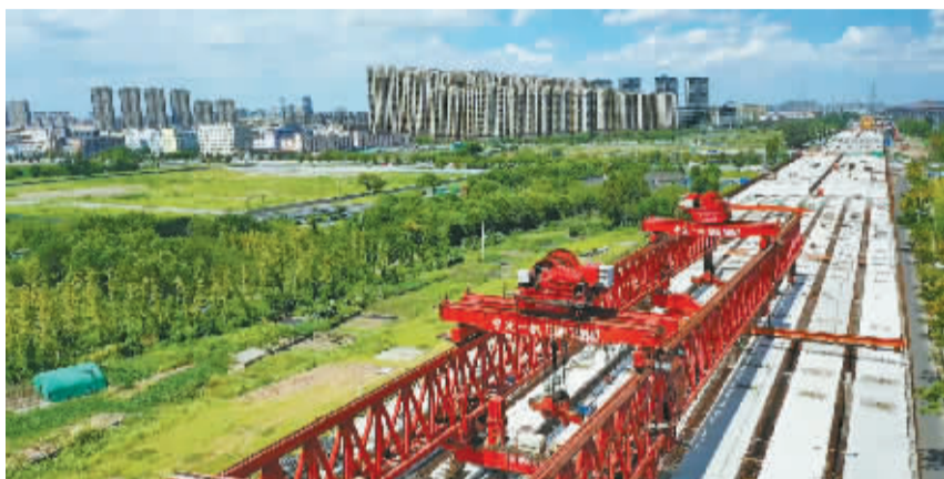
建设中的鄞州大道快速路。
