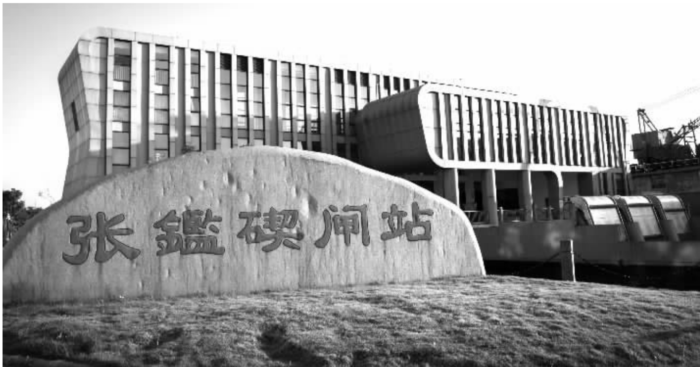
张鑑硨闸站。 应海曙 摄
