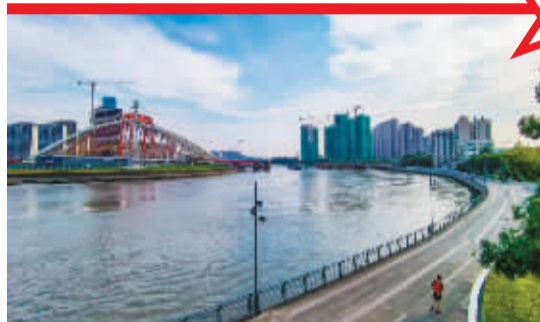
68天前,主桥在岸上拼装完成后,准备实施顶推。
