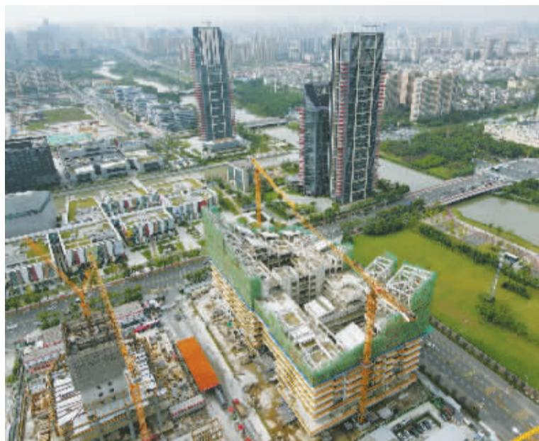
NFCC封顶。东部新城开发建设指挥部供图
