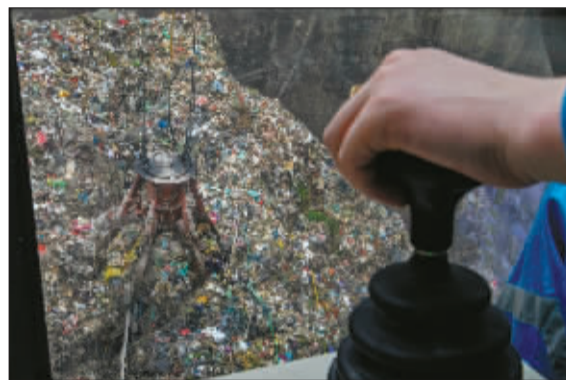
垃圾池内环境恶劣,卸料大厅是全封闭的。吊车操作工在吊车控制室内进行操作,对垃圾池内垃圾进行搬运、搅拌和倒垛,把已发酵垃圾搬运至焚烧炉入口。
