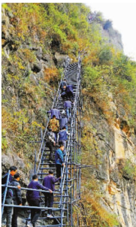
▲曾经的“悬崖村”架设了钢梯。
