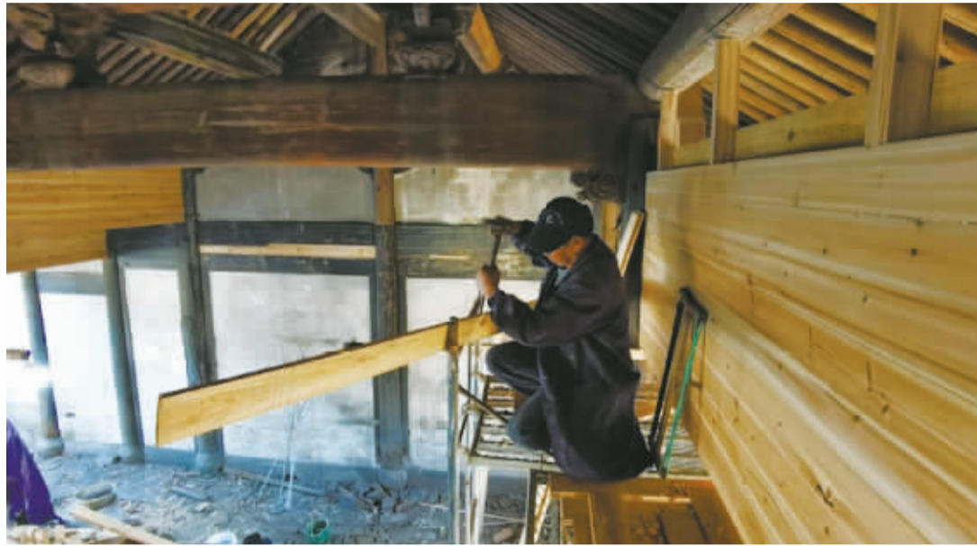
工人正在修复大梁。记者 刘波 摄
