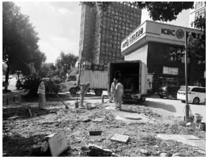
嘉华大厦雨污分流项目建设。通讯员供图
