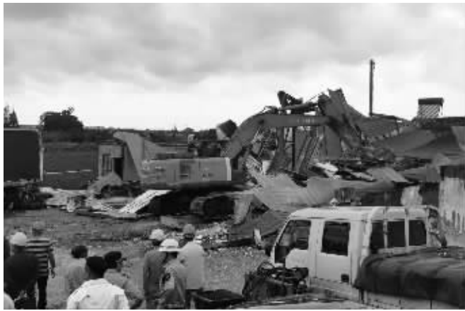
高阳路拆除违建。
