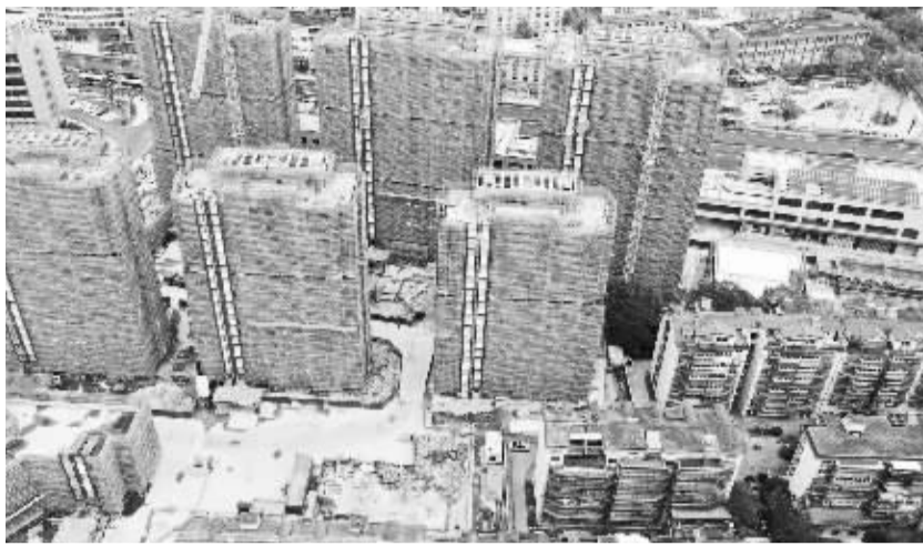
宁波危旧房改造建设二期项目航拍图。
