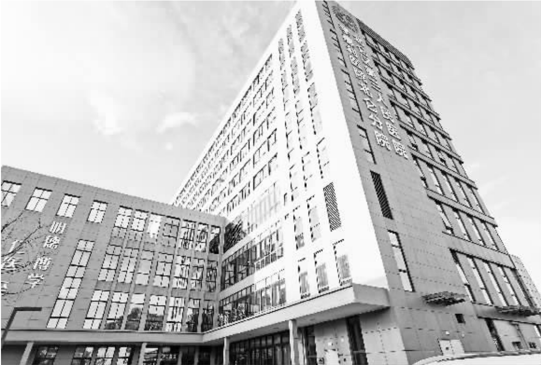
新住院大楼外景。
