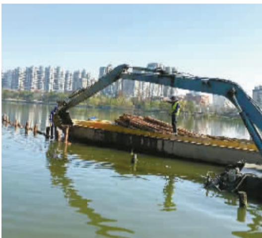
日湖公园施工现场。
