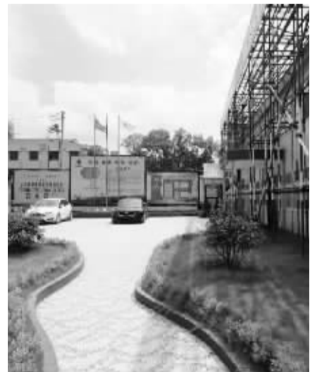
新城河项目工地
