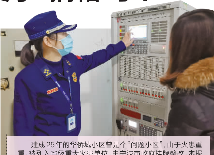
消防执法人员正在检查火灾自动报警系统。
