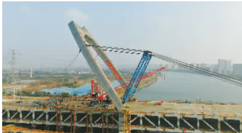
竖转中的西洪大桥。通讯员供图
