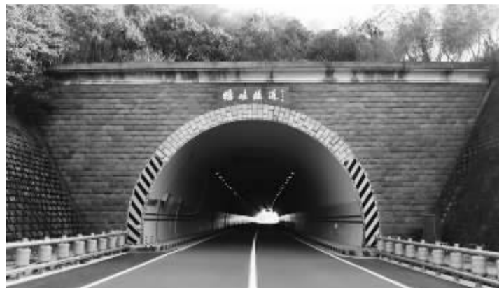
改造一新的瞻岐隧道。
