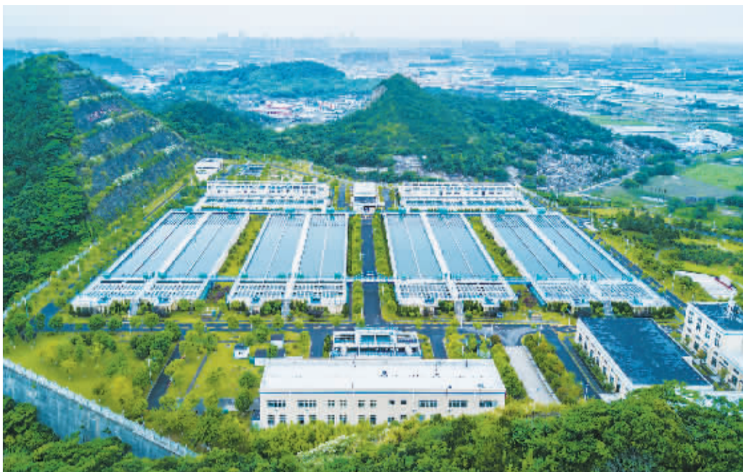
东钱湖水厂航拍图。
