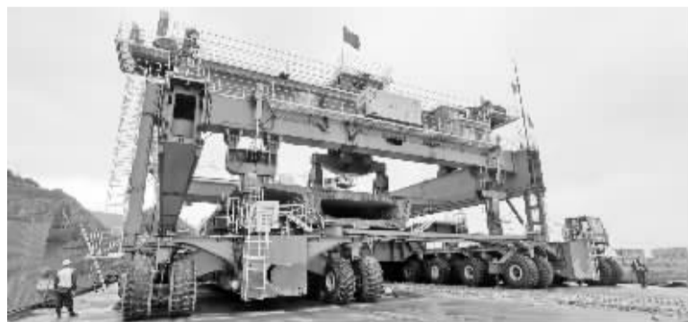
象山湾疏港高速项目虎年第一榀整孔预制箱梁顺利架设完成。
