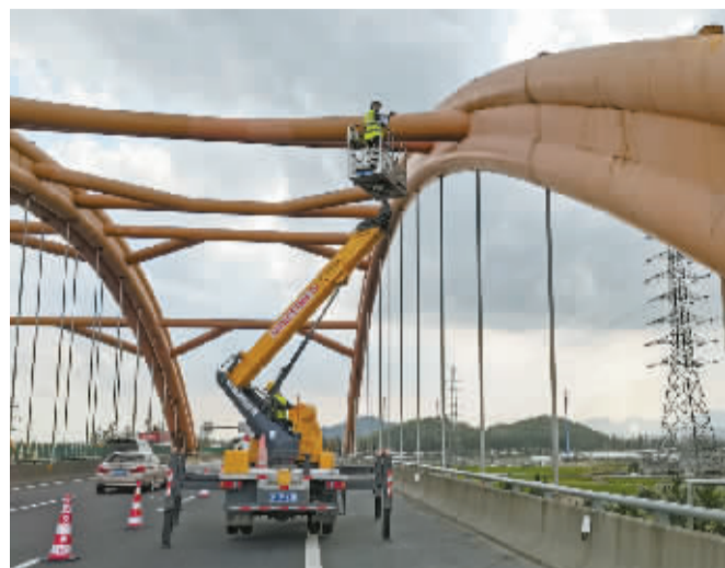
监测人员对路网进行技术评定。
