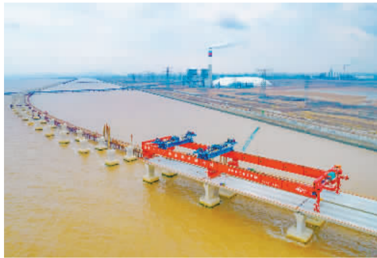
建设中的杭甬高速公路复线。通讯员供图
