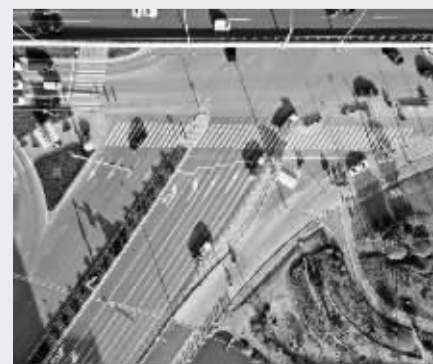
路口改造后,工程车右转弯更安全(航拍)
