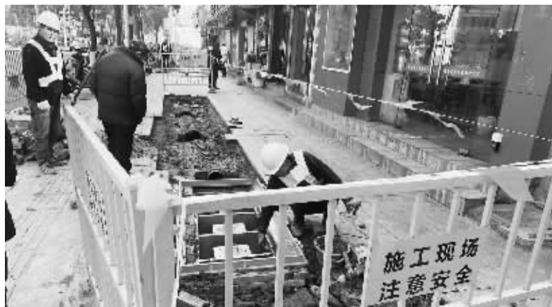
隔油池新建安装工程施工现场。
