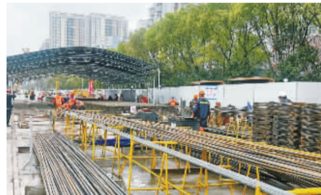
施工现场。记者 周科娜 摄
