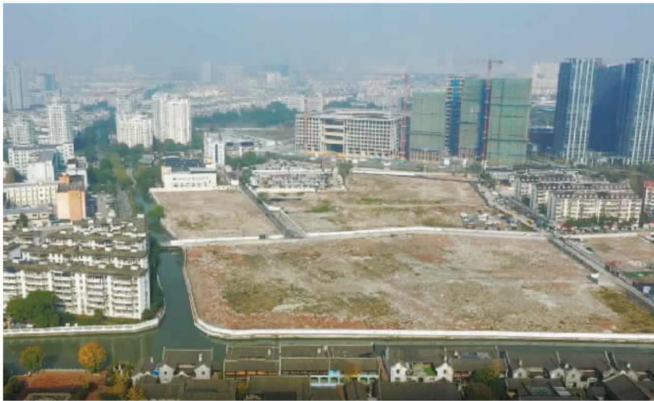
已经拆平的三市地块。记者 杨辉 摄
