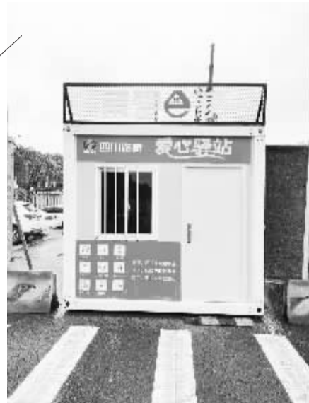
工地上的“甬爱e家”服务站。
