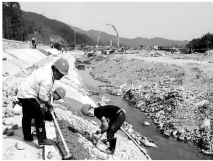
施工人员对海曙区樟溪河水毁工程进行修复。
