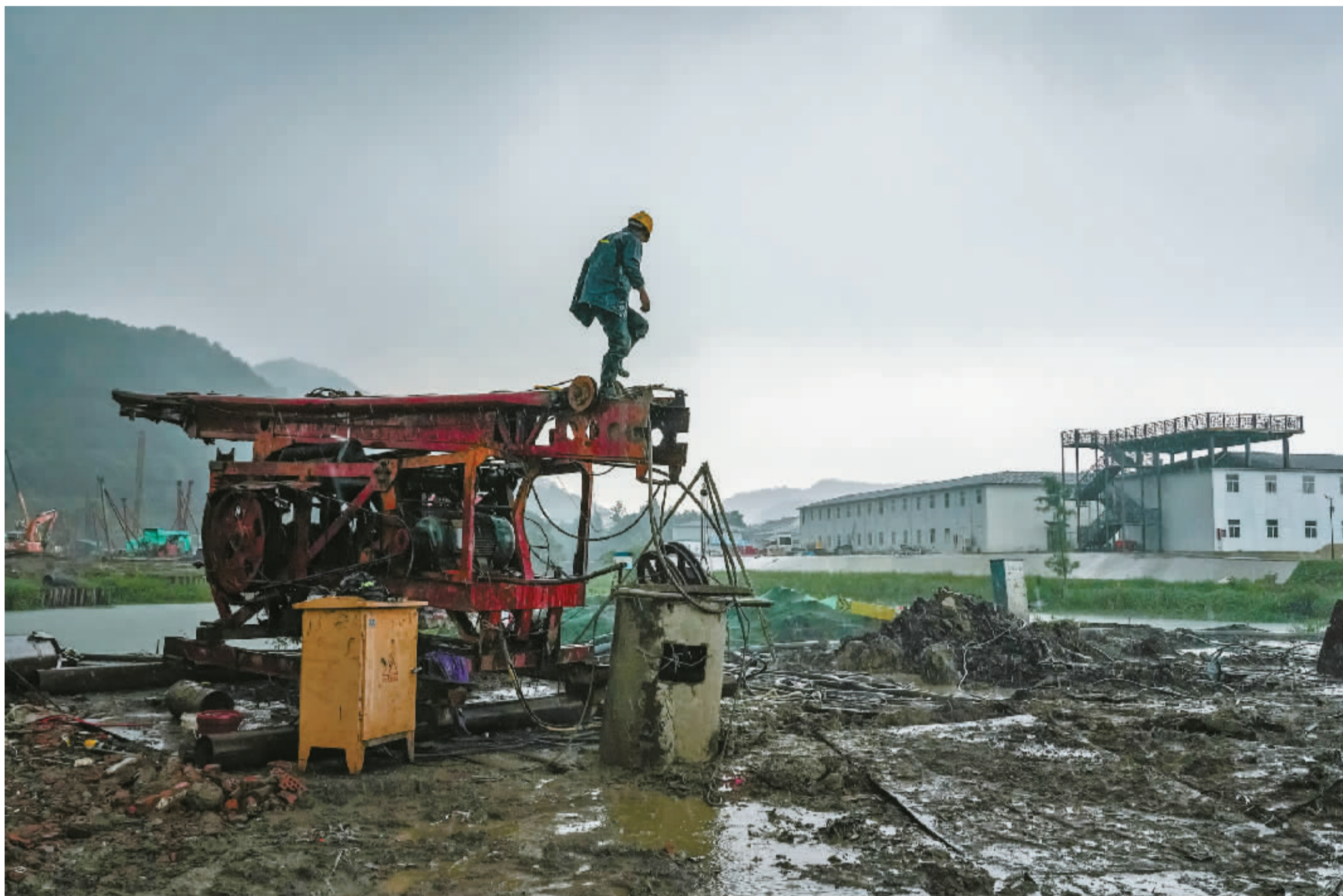
2020年7月9日,工人站在高高的打桩机上,顶天立地,像个雕塑。
