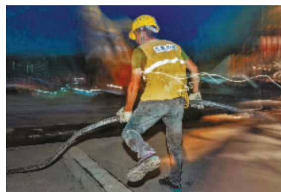
2020年5月24日,电工在夜间作业。
