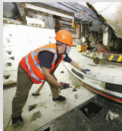
翟小田在吊装双轨梁。
