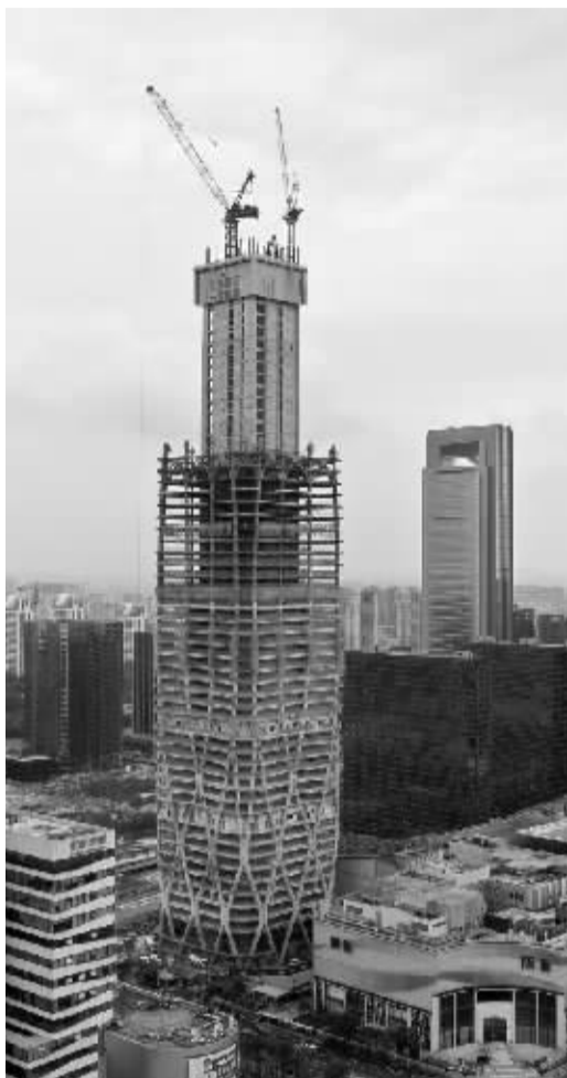
建设中的宁波中心大厦。记者 杨辉 摄
