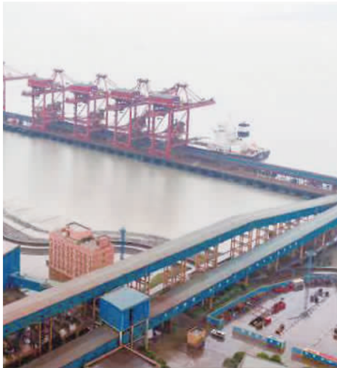
宁波舟山港穿山港区中宅矿石码头二期项目。 通讯员 蒋晓东 摄
