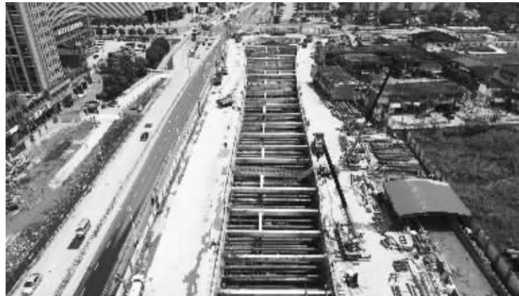
3号线二期骆驼桥站施工现场。
