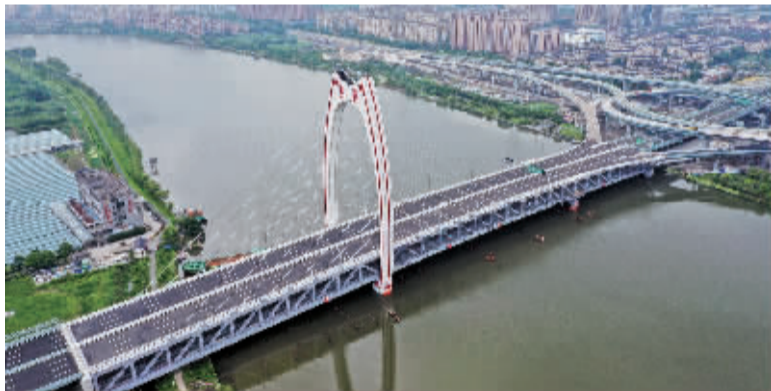
西洪大桥及接线工程(环镇北路-北环快速路)
