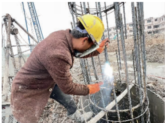
在重点水利工程现场施工的建设者。
