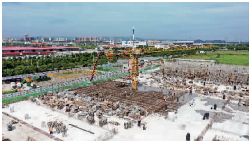
建设中的江北下沉式再生水厂。
