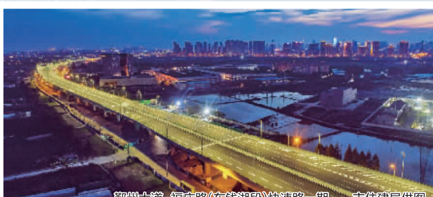
鄞州大道-福庆路(东钱湖段)快速路一期。 市住建局供图
