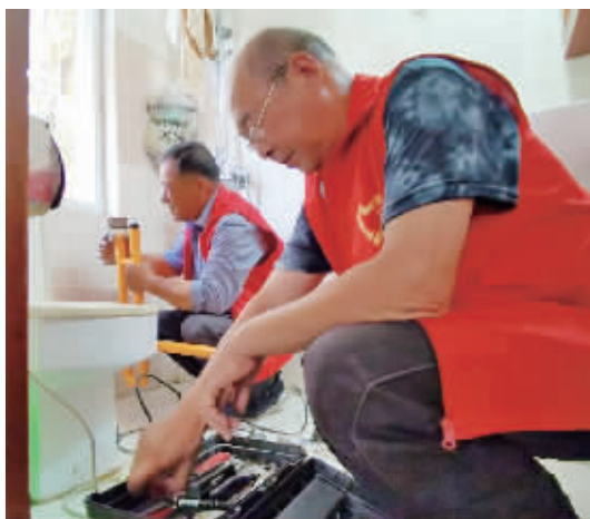
“邻里帮”维修应急小分队上门为老人安装卫生间扶手。 记者 刘波 摄
