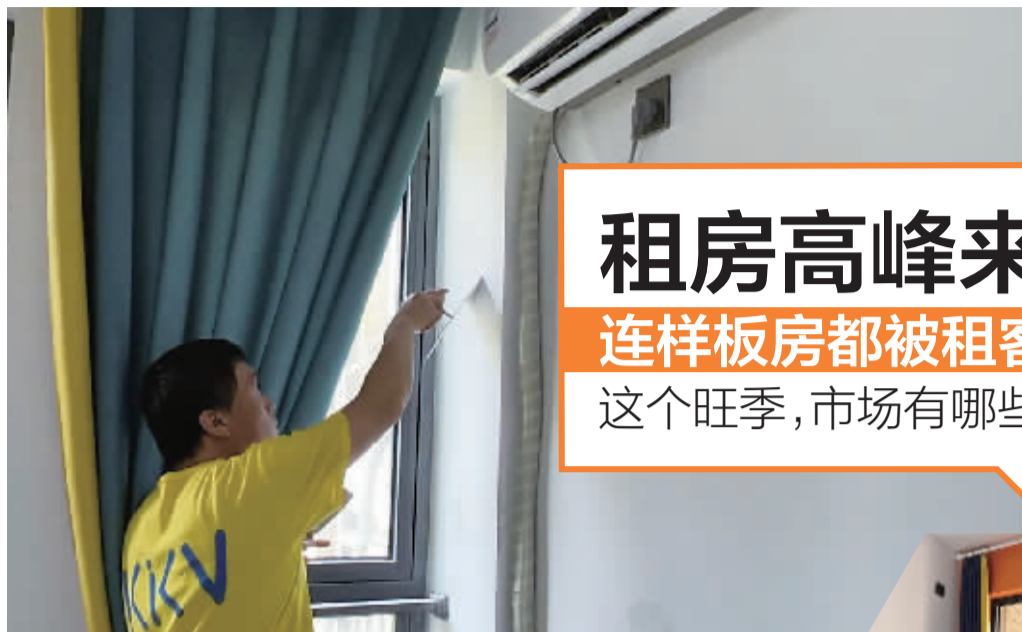
租赁住房现场装修场景。
