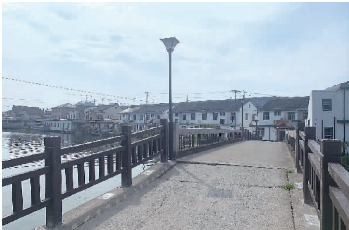
改造后的四碛桥。
