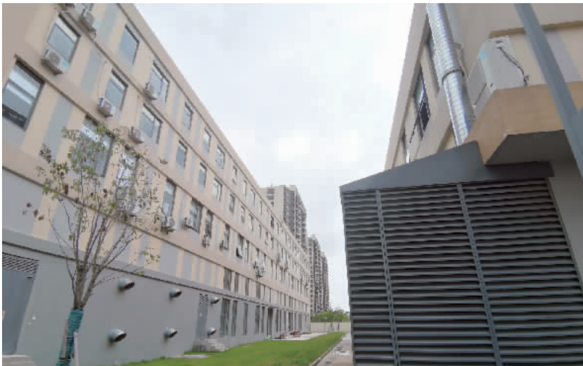
园区内,企业为了降噪,都主动将设备用房进行了隔音处理。 记者 滕华 摄
