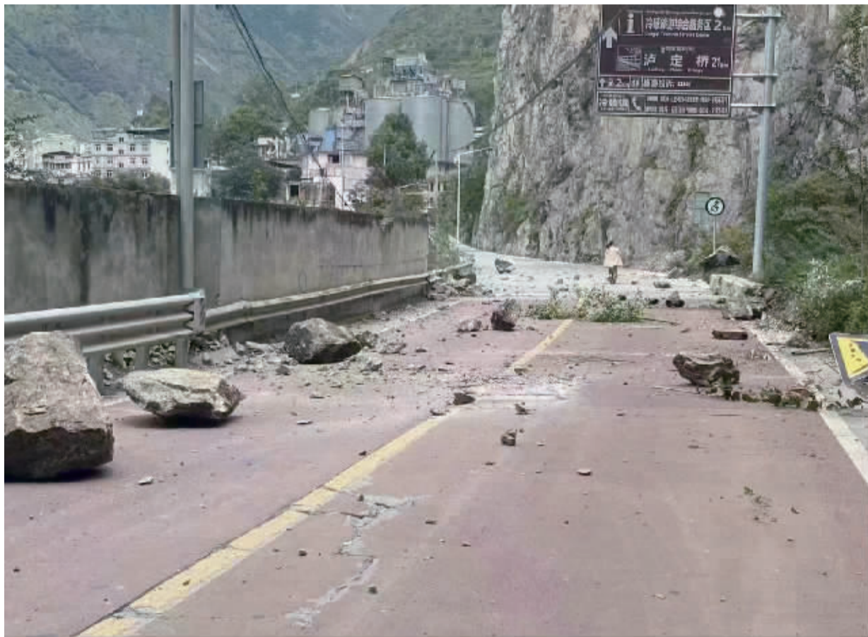
山石掉落在四川省甘孜州泸定县冷碛镇附近的道路上(9月5日摄)。
