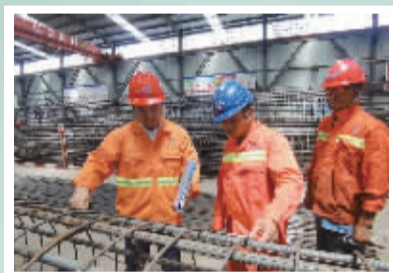
前天, 鄞州大道快速路项目工地, 工人正在赶工。 记者 刘波 摄
