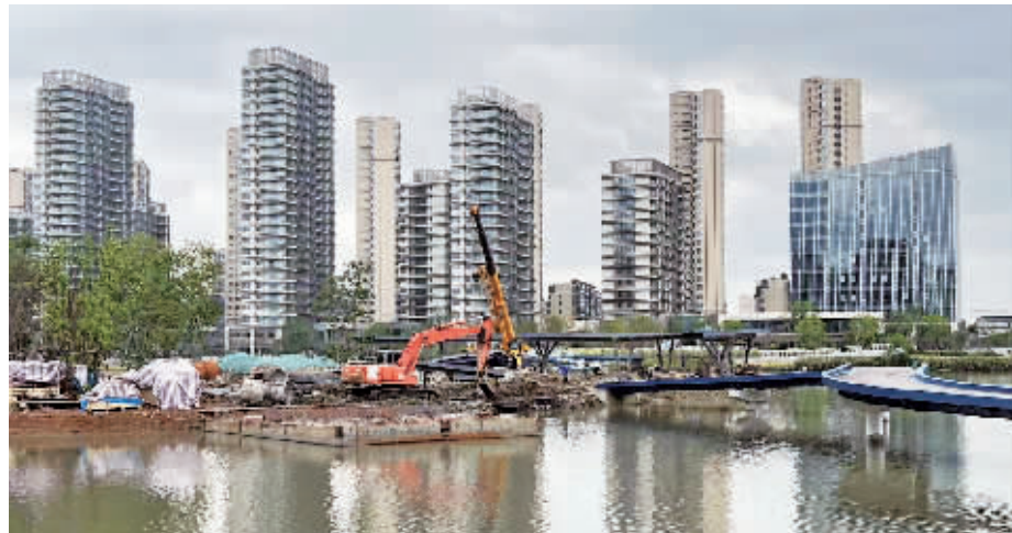
湖心岛施工现场。
