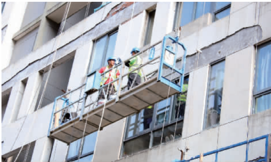
外墙维修施工。
