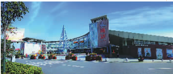
大桥南岸服务区。
